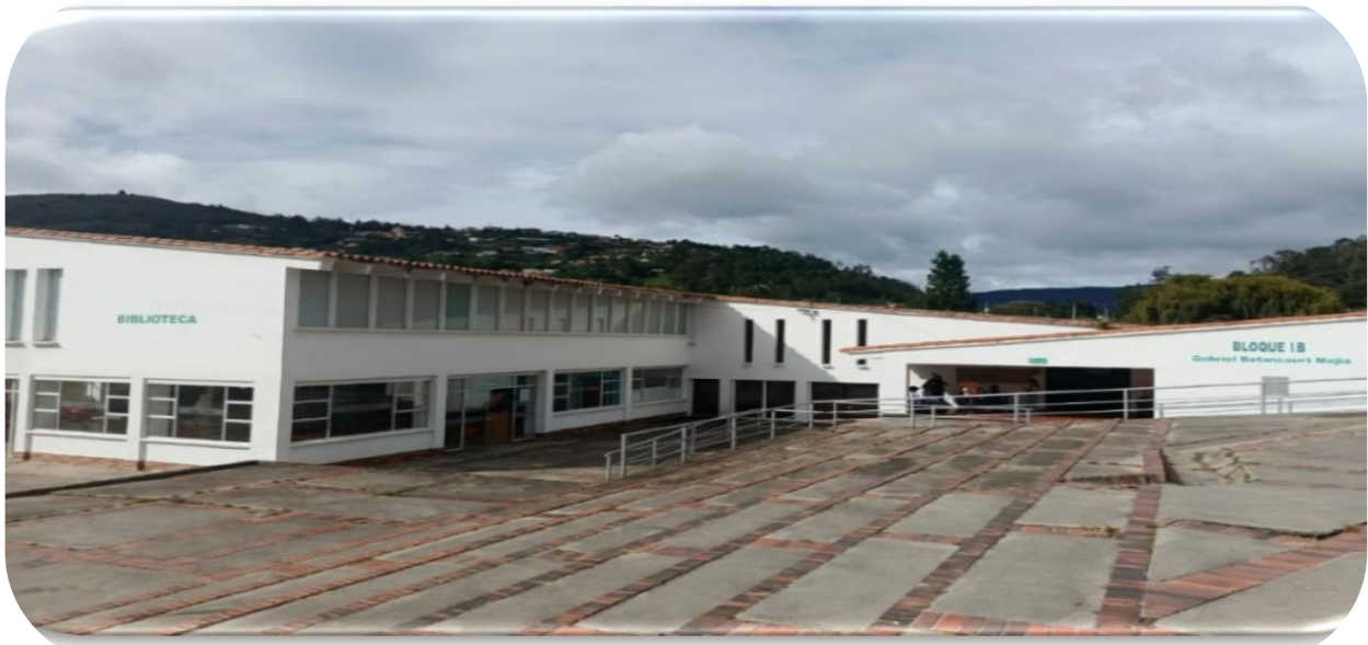
Acceso para población en situación de discapacidad
